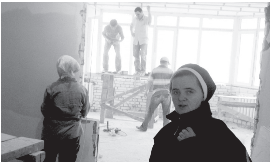
Во время ремонта квартиры, где будут жить елизаветки.
